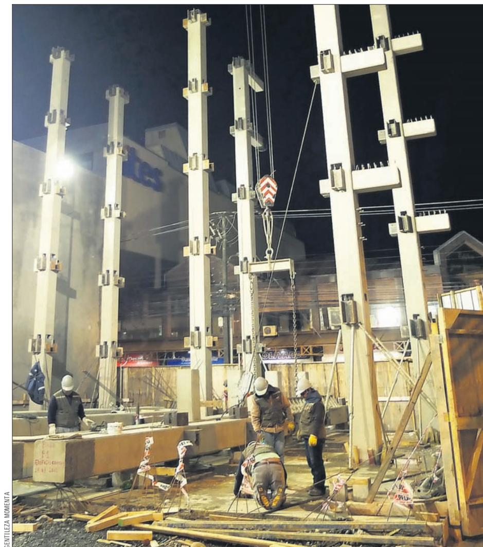
EJEMPLO.— En nuestro país ya se construyen edificios prefabricados con aislamiento sísmico.
